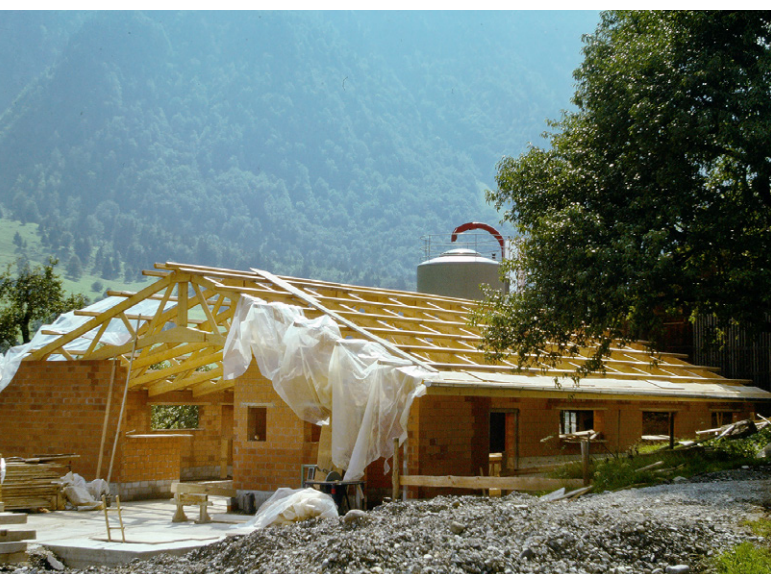
Der neue Stall während der Bauphase im Sommer 1977.
