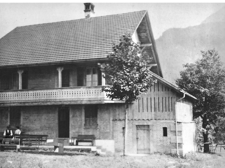
Diese Fotografie um 1910 zeigt das heutige Wohnhaus im «Originalzustand» wie es um 1900 erbaut worden war. Der hintere, westliche Anbau (Pferde-, Schweinestall und Schopf) wurde 1964 und 1990 zwei Mal zu Wohnraum erweitert.
