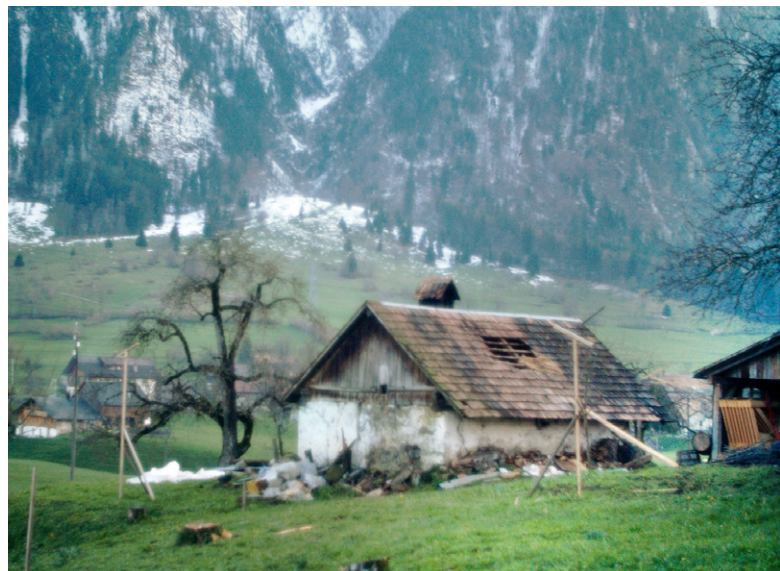
Im Jahr 1977 musste das baufällige alte Ofenhaus einem neuen Stall weichen. Die Bauprofile stehen bereits.
