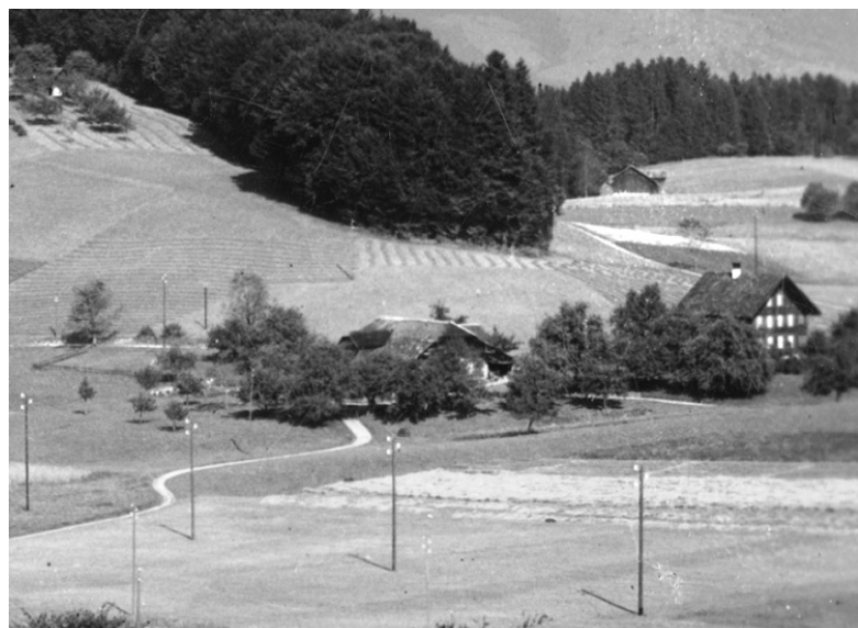
Dank diesem Ausschnitt einer Fotografie, welche vor 1940 entstanden ist, hat man eine Vorstellung, wie das ehemalige Wohnhaus Nr. 54 (Bildmitte) ausgesehen haben mag. Am rechten Bildrand das um 1900 erbaute neue Wohnhaus Nr. 54B.
