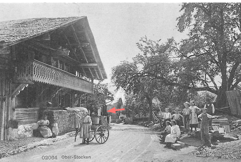
Die Schule ist aus, so stellt sich die Dorfjugend um 1910 bei der Kreuzgasse bereitwillig dem Fotografen. Links das heutige Haus von Rolf Bruni. Angrenzend (Pfeil) befand sich bis 1882 das Schulhaus der Gemeinde Oberstocken.
