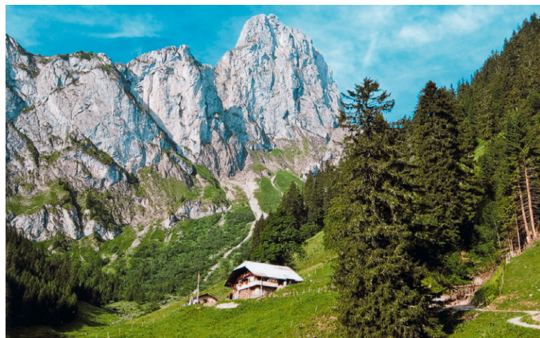
Die idyllisch gelegene obere Bachalp-Hütte wurde in den Jahren 1945/46 neu erstellt (Bild oben) und der Stafel der unteren Bachalp erhielt bereits im Jahr 1936 eine neue Hütte (Bild unten).
