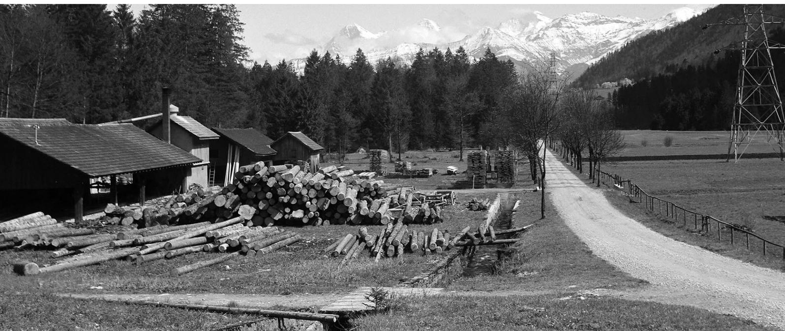
*Seit dem Jahr 1929 befindet sich das Sägewerk des Wilhelm Theilkäs am Rand des Sewliswald in Niederstocken (Aufnahme aus dem Jahr 1947). Die gepolterten Trämmel wurden jeweils mittels eines durch Pferde gezogenen Aufzuges auf die Sägewagen befördert.*
