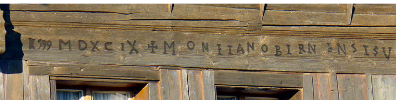
Die Inschrift eher unbeholfenen Charakters am Bundbalken deutet auf einen zwar unbekannten, jedoch stolzen und unabhängigen Erbauer des Häuschens hin.
