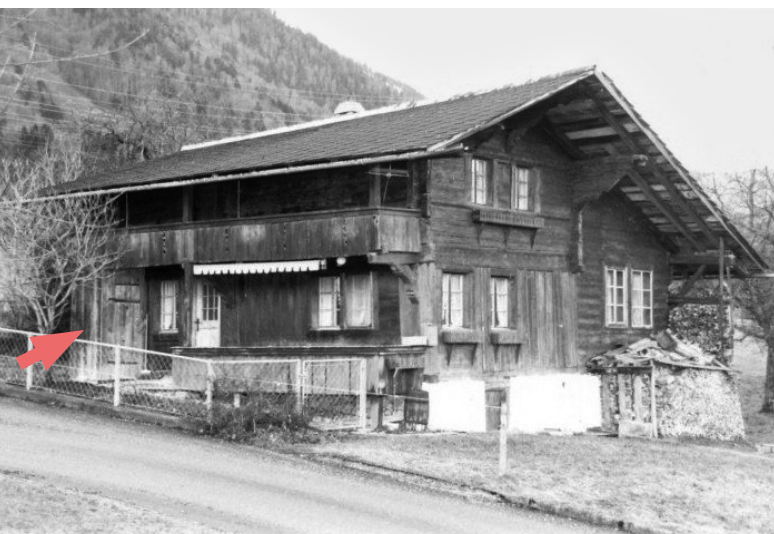
Die sanitären Einrichtungen beschränkten sich vor der grossen Renovierung auf das Nötigste. Glausers und ihre Vorgänger waren noch auf das «Plumpsklo» angewiesen (Pfeil). Diese «Bedürfnis-Verrichtungsstätte» wurde in den alten Lagerbüchern jeweils elegant als Abtritt mit Sekretskasten umschrieben.
