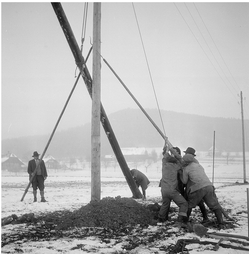
Bild links: Einheimische Arbeiter unterstützen Fachkräfte der BKW beim Aufstellen der Leitungsstangen. Bild rechts: Der BKW-Leitungsmonteureinsatz.
