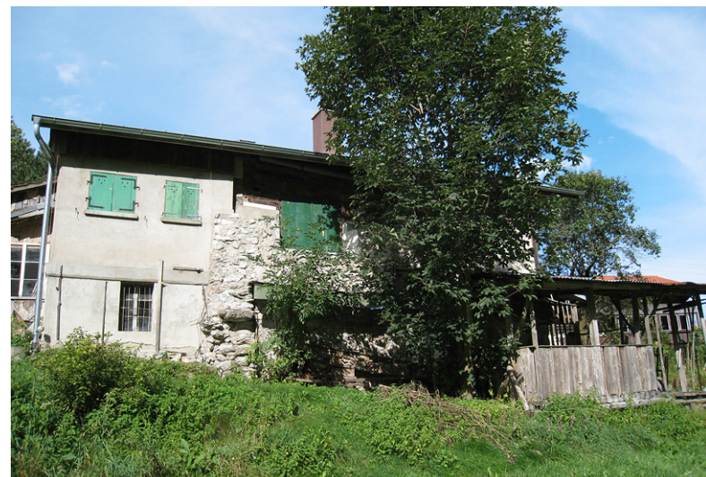
Abb. 6: Südwestliche Ansicht im Jahr 2012 mit Schopfanbau aus der Bauphase 7. Auch die weiss getünchte Betonmauer stammt aus dieser Zeit (1933).
