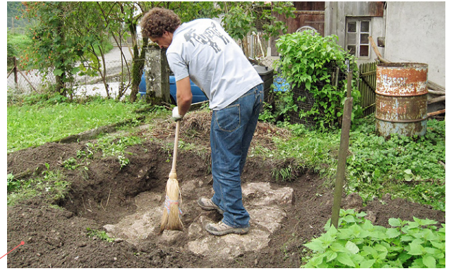
Abb. 14 (ADB): Sondage 4. Diese wuchtigen Grundmauern waren rasch gefunden und freigelegt.
