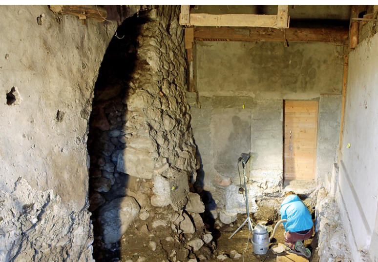
Abb. 11 (ADB): Mit grösster Sorgfalt säubert ein Mitarbeiter des ADB die südliche Ecke des Schiffs. Darüber ist die Holztür zum Hühnerstall zu sehen und links ist der Chorbogen mit dem originalen Wandverputz zu erkennen.
