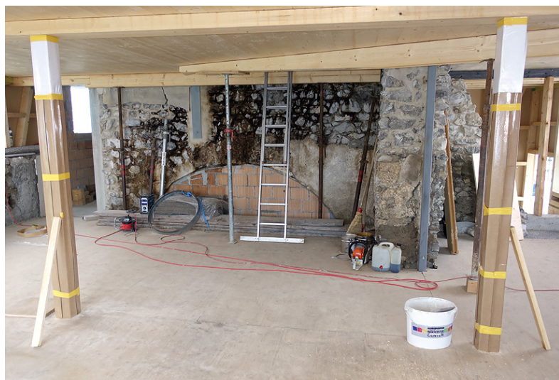
Abb. 22 (ADB): Stand der Aufbauarbeiten im Oktober 2018. Der ganze Chorbogen ist bereits zugemauert und das Neuholz für das zukünftige Wohnzimmer eingezogen. Die Bauplanung sah vor, dass historische Baumassee in den Neubau einfliesst und sichtbar verbaut wird.
