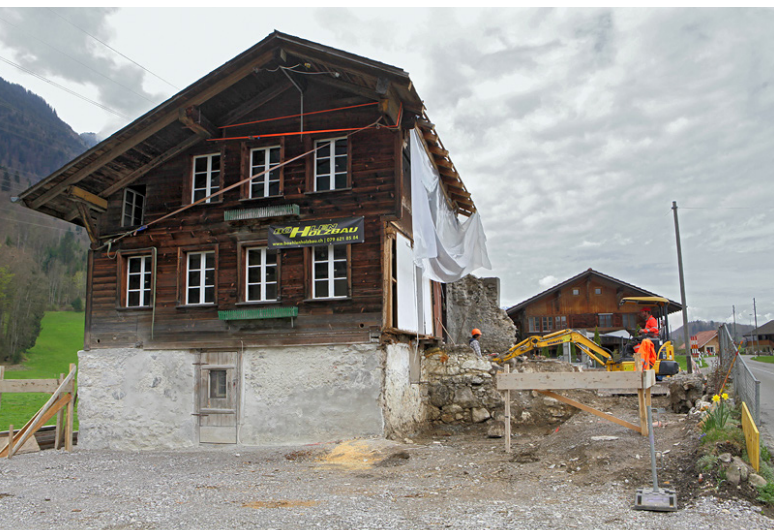
Abb. 19: Stand der Abbrucharbeiten im März 2018. Das Wohnhaus, über dem ehemaligen Chor, steht noch. Rechts sind die Grundmauern der Sakristei und dahinter der wuchtige Rest der Chormauer zu erkennen.
