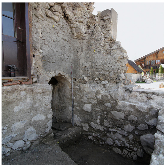
Abb. 21 (ADB): Stand der Abbrucharbeiten im Juni 2018. Wir blicken von der Dorfstrassen-seite über die ehemalige Sakristei zum schmalen Durchgang in den Chor. Durch diese Tür gelangte der Priester in den Chorraum, zwecks Abhaltung einer heiligen Messe.
