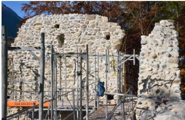
Ende Oktober 2020 begann die Gerüstbaufirma mit dem Abbau des Schwerlastgerüsts und baute die notwendigen Elemente an der Süd- und Ostmauer wieder auf.
