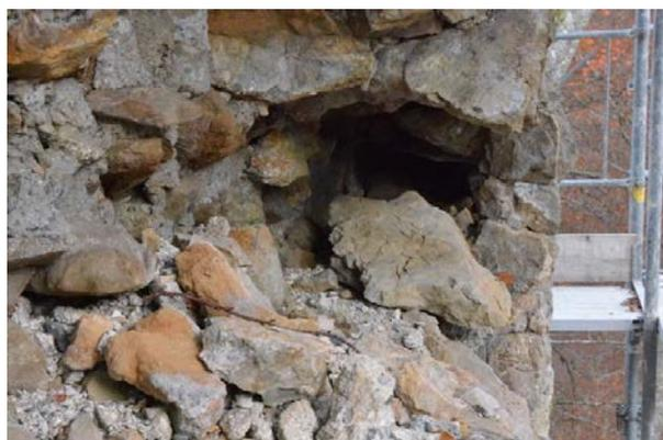
Neben den Mauerkronen, welche mit neuen Kalksteinen geschützt und mit Mörtel verfugt werden mussten, gab es viele aufgebrochene Mauerstellen auf der Innen- wie der Aussenseite zu ergänzen.
