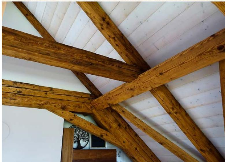
Dachkonstruktion vorher und nachher. Dank der «natürlichen» Rauchimprägnierung überdauerte das Holz die Jahrhunderte, verschont von Wurmbefall.
