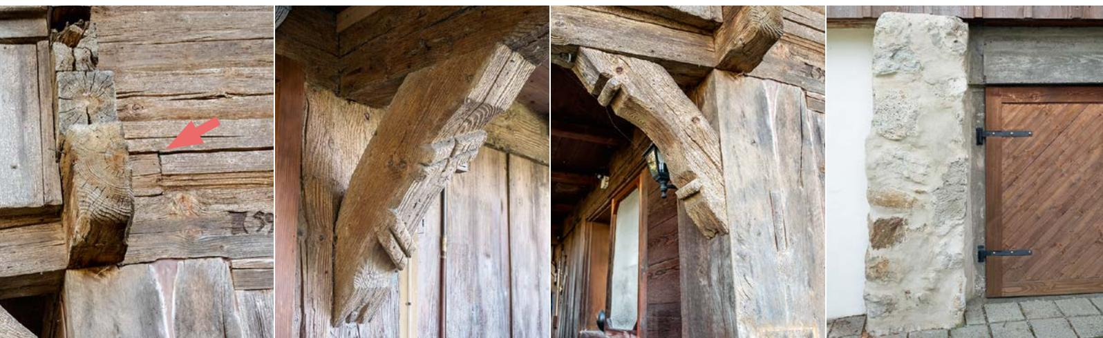
Ursprüngliche Konstruktionselemente des «Hüseli» – Bilder von links: Drei abgesägte Bundvorstösse (Pfeil) dienen als Träger einer ursprünglichen Ecklaube von der Ostseite (noch bestehend) der Front entlang. Konsole im Originalzustand. Eicherner Eckständer verbunden mit wiederum originaler Laubenkonsole. Originalmauer im Kellerbereich, fachgerecht restauriert (evtl. Restbestand des ursprünglichen Scheunenbaus). Rechts davon ehemaliger Eingang zu einem Ziegenställen.
