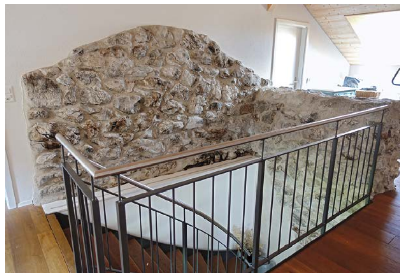
Abb. 24: Die heutigen Wohneinheiten mit geschickt integrierter Bausubstanz aus vorreformatorischer Zeit.
