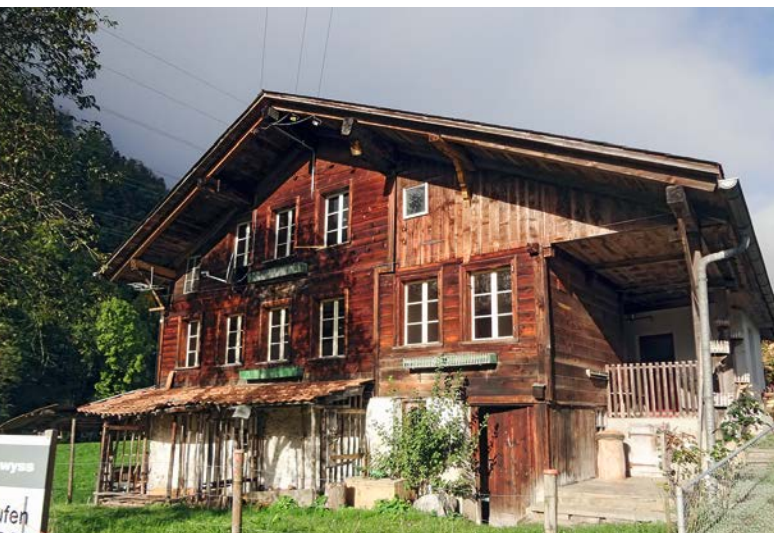
Abb. 10: Das zum Verkauf stehende Gebäude im Sommer 2012. Im September 2012 begannen die ersten Untersuchungen und Sondierungsgrabungen des ADB.
