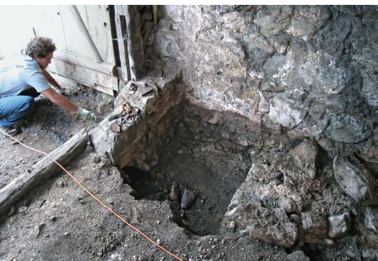
Abb. 12: Ein Mitarbeiter des ADB beim Säubern eines Teils der nordöstlichen Schiffswand die an die Chorwand anschliesst. Rechts ist das Fundament eines Nebenalters zu sehen (siehe dazu auch Bild 16).
