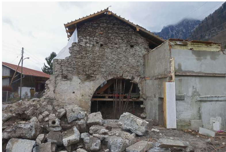
Abb. 20: Das Oekonomiegebäude, Schopf mit Garage, ist bereits abgebrochen nur der Hühnerstallanbau steht noch. Zu sehen ist die hohe Chorwand mit dem gestützten Chorbogen. Dahinter erkennt man den Holzfußboden der alten Küche.
