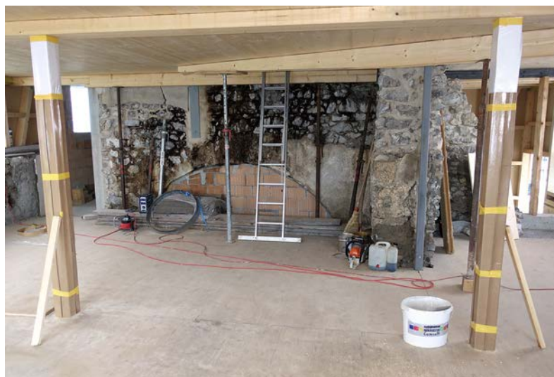
Abb. 22 (ADB): Stand der Aufbauarbeiten im Oktober 2018. Der ganze Chorbogen ist bereits zugemauert und das Neuholz für das zukünftige Wohnzimmer eingezogen. Die Bauplanung sah vor, dass historische Baumasse in den Neubau einfließt und sichtbar verbaut wird.
