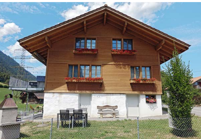
Abb. 23: Die Südostfront des «Chappeli» im Jahr 2026, heute Stockentalstrasse 33, vormals Hintere Gasse 28 in Niederstocken.
